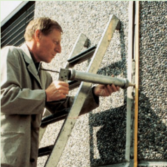
Liikuntasauaman tiivistäminen PCI Elritan 100:lla pesubetonijulkisivussa.
