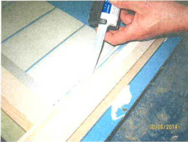
Kuva 1: Kynnyksen alumiinilistan asennus.
