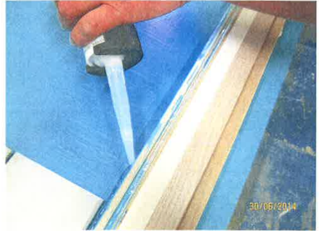
Kuva 2: Kynnyksen alumiinilistan asennus.
